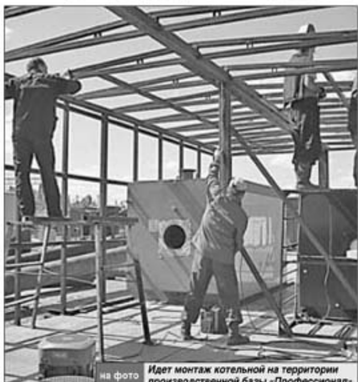
на фото Так выглядит автоматизированная компактная блочно-модульная котельная 0,25 МВт
